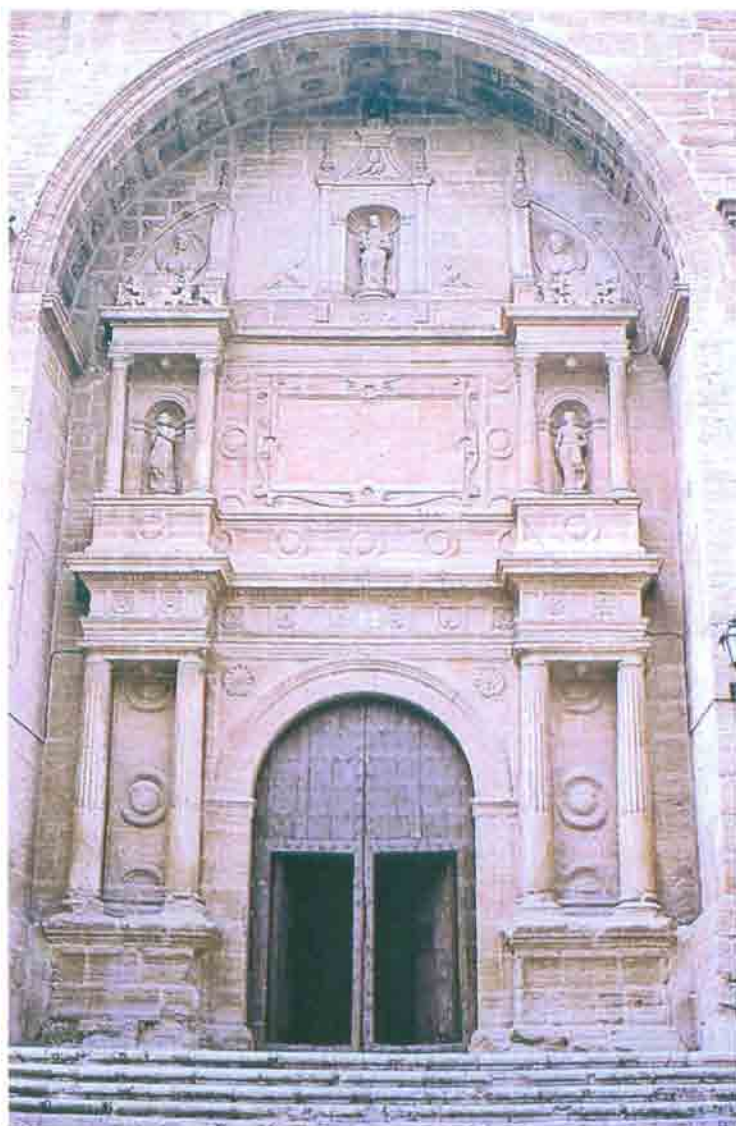
11. Portada de la iglesia de San Blas, de Villarrobledo, que como la de la Asunción se considera ejemplo de "portada vandelviresca".
