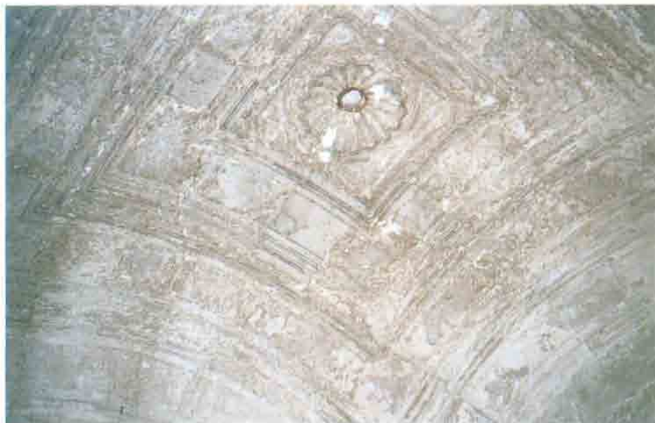
12. Detalle de la bóveda baída, sobre la escalera de acceso al coro alto, de la torre de la epístola de la iglesia parroquial de Almansa.
