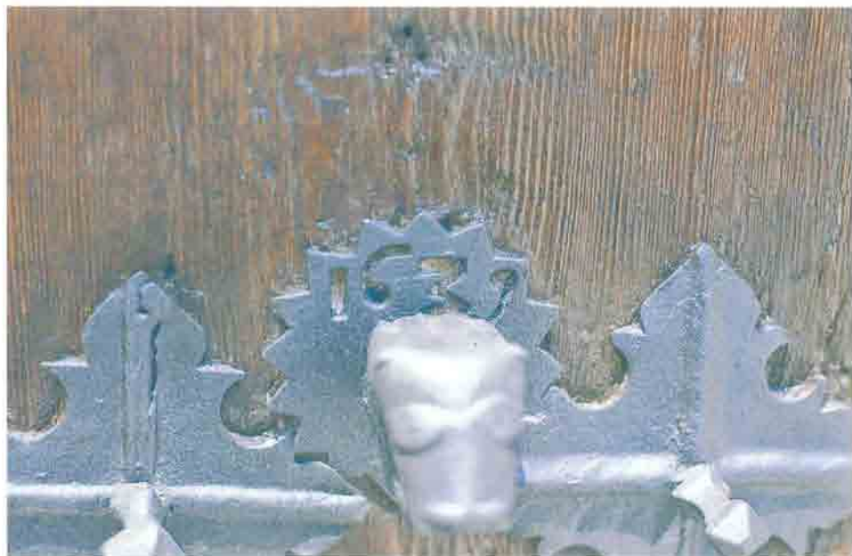
13. Detalle del mascarón de la puerta de Figuerola, en la que aparece la fecha de ejecución –1639–, costeada con parte de la herencia del "maestro cantero".
