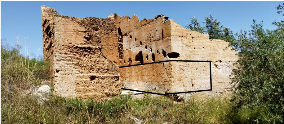
Figura 6. Restos constructivos y remarcado de las cajas de tapial con graffiti
